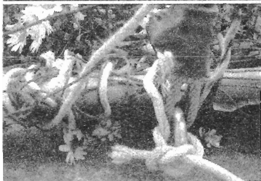
ネットの一番下に直径3センチの塩ビ管を匍く 新河岸小方式
